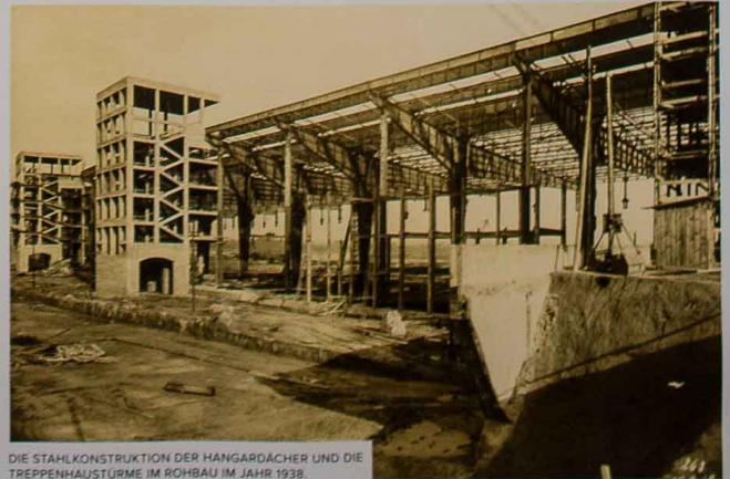
DIE STAHLKONSTRUKTION DER HANGARDÄCHER UND DIE TREPPENHAUSTÜRME IM ROHBAU IM JAHR 1938.
