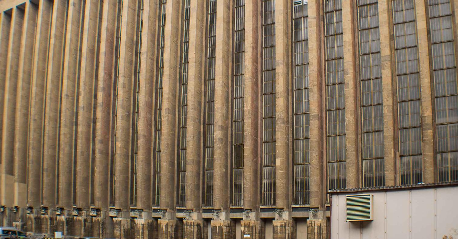
Die **Außenfassaden** der zur Bauzeit fertiggestellten Flughafengebäudeteile sind aus Sandstein. An einer kleinen Stellen wurde der Sandstein probenhalber gereinigt (siehe Foto) und es wird deutlich wie beeindruckend golden der Flughafen gewirkt haben muss.
